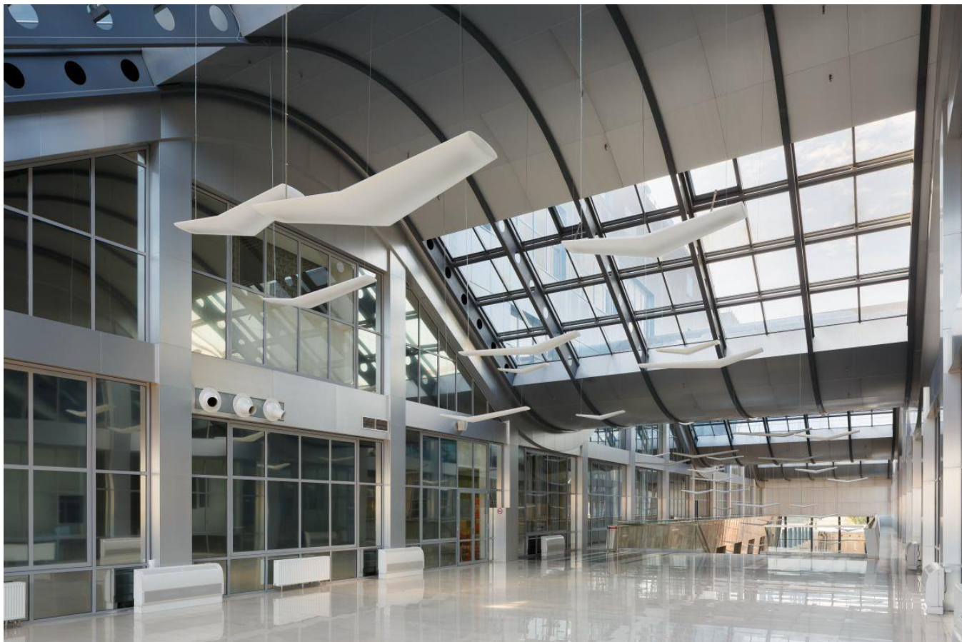
Рисунок 9 – Пример проектного решения с устройством покрытия атриума из негорючих материалов
